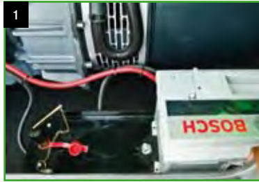
1. On-off battery switch / Desconectador de batería / Batterie et isolateur.
